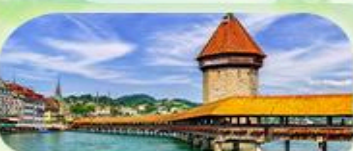
สะพานไมซ์าเปิล
