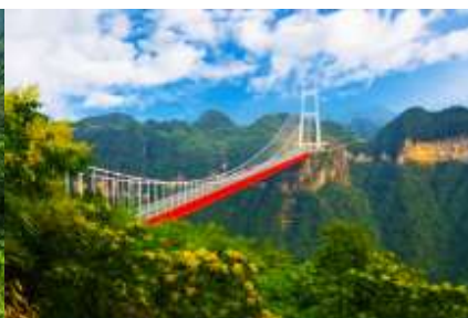
สะพาน ไอ้อ้ายถ่าเจียว
